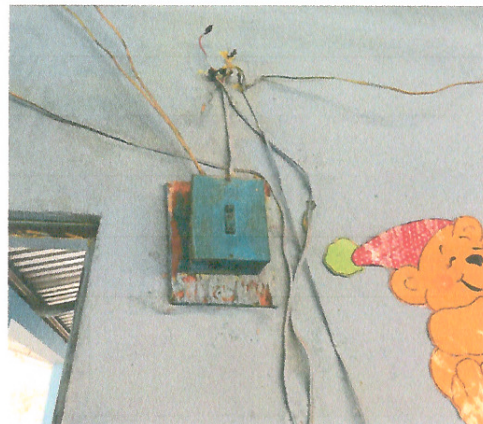
Foto 4: Reparación del sistema electrico
