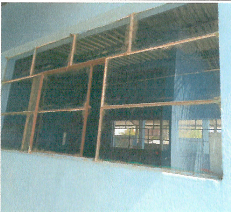
Foto 3: Reparación de ventanas
