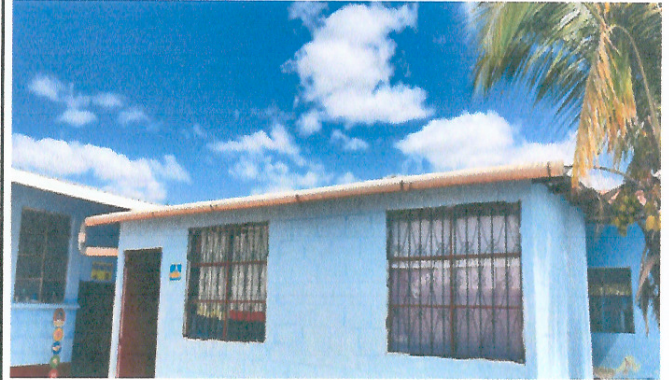
Foto 2: Repación de caída de aguas pluviales
